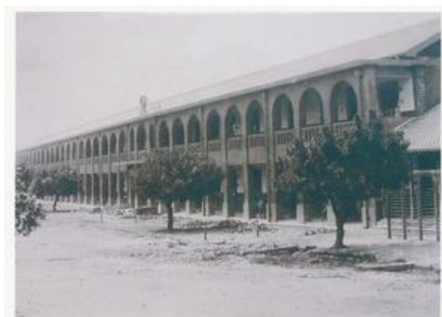
圖 7.1937 年因應學生不斷增加，彰化公學校將舊木 造教室拆除，興建二層樓鋼筋混凝土加強磚造結構 的北棟教室，採現代主義風格，隔年完成。
