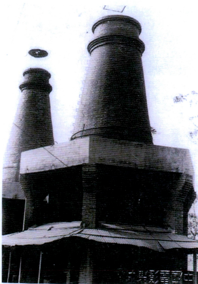
圖 1-31：北投「台灣工礦公司」生產耐火磚的豎窯。
