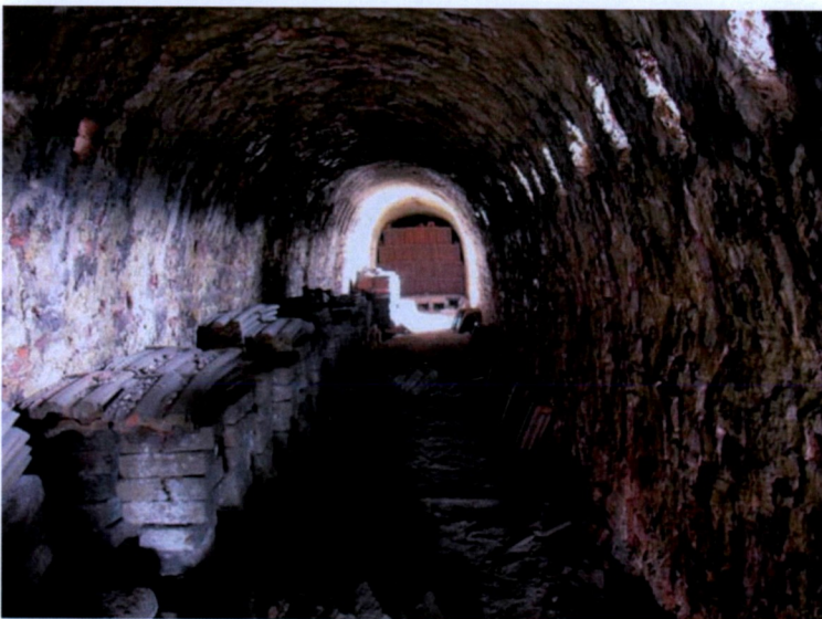
圖 1-12：新敏隆蛇窯窯床階梯式。
