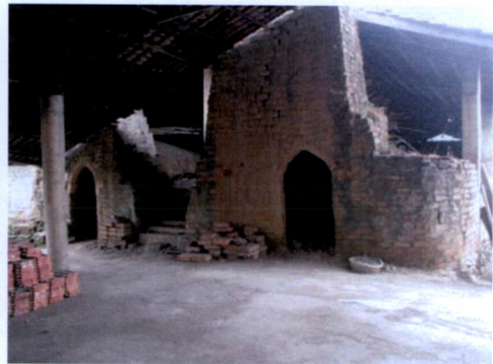
圖 1-10：窯尾煙囪有出入窯門。
