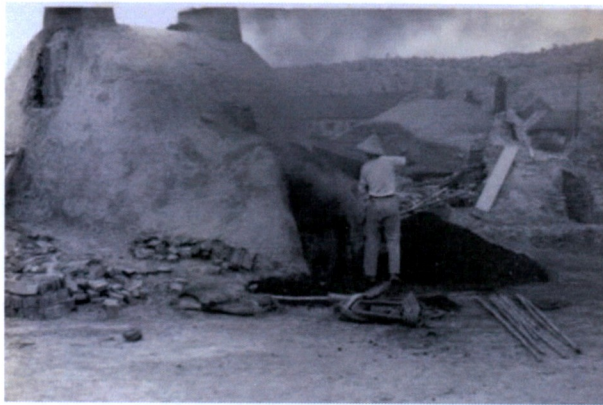
圖 1-20：專燒文化瓦的黑瓦窯。
