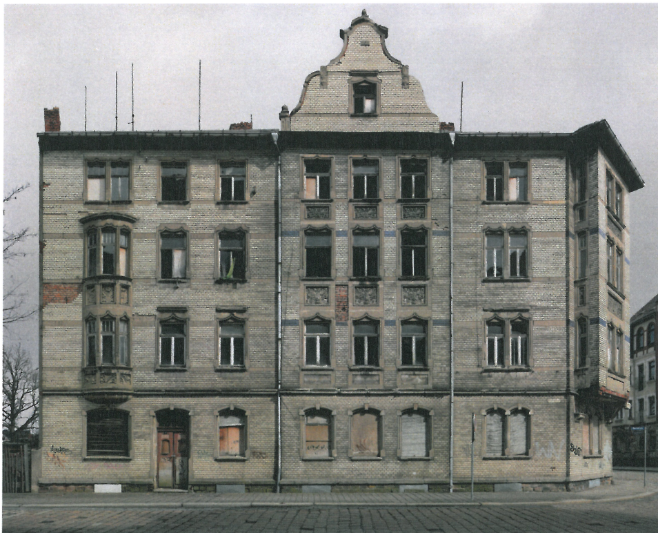
位於德東城市 Weißenfels 小城裡的一棟建築物，這個小規模的城市中四處可見破敗的房屋，此棟房屋巨大的矗立在街角，磚面在時間的洗刷下還透著隱約的光澤，密閉的一樓門窗對比著上層空洞的窗口。一塊綠色的窗簾在風大的日子裡彷彿有生命的飄動著。
