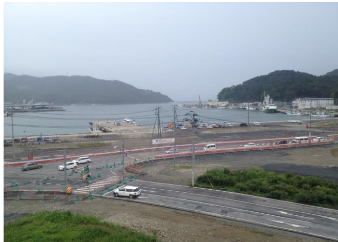
海港重建工程
