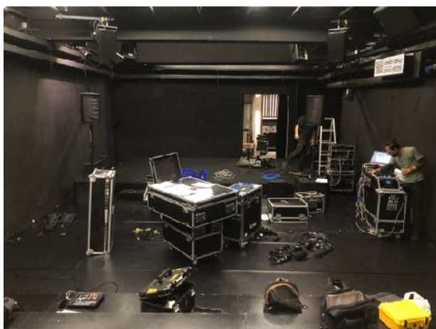
安裝一樓舞台
