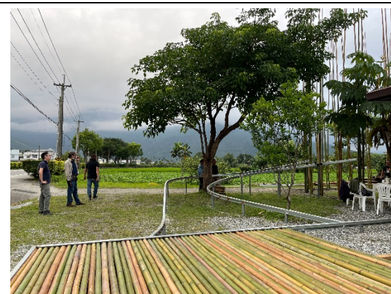
斜坡廊道鋼材結構基礎工程
