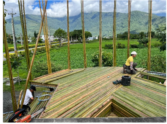
高台結構工程
