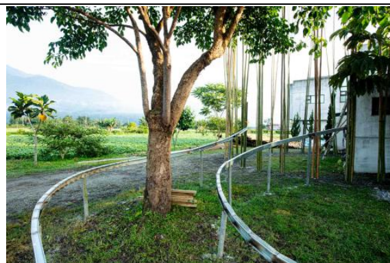
斜坡廊道鋼材結構基礎工程
