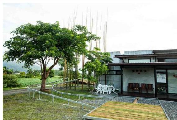
斜坡廊道鋼材結構基礎工程
