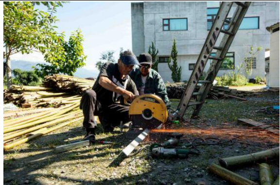
鋼鐵架構固定工程
