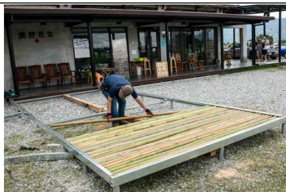
平台鋼材結構基礎工程
