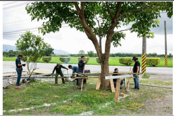
鋼材結構處理
