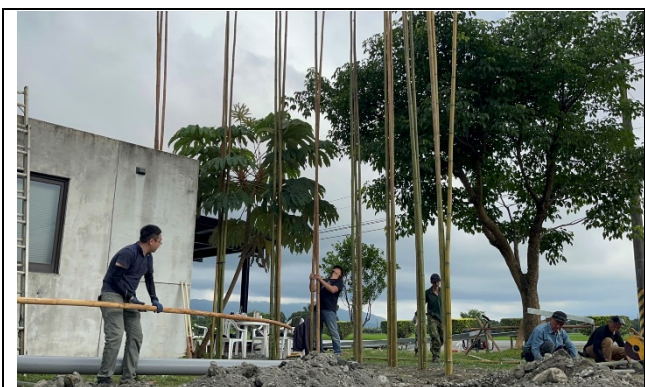
地基基礎結構工程
