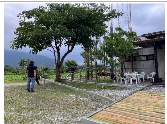
平台鋼材結構基礎工程
