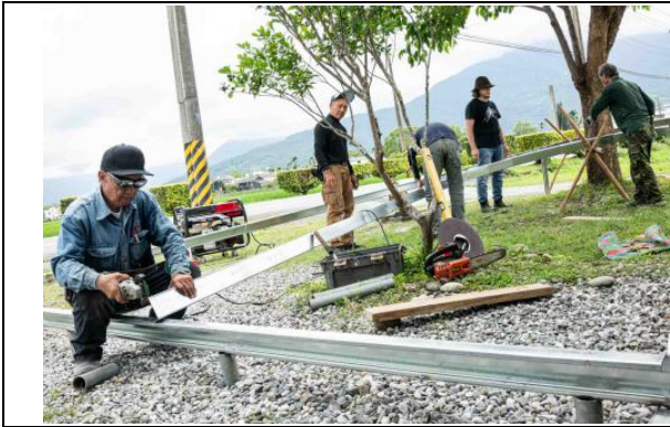
鋼材結構處理
