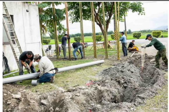
地基開挖立結構
