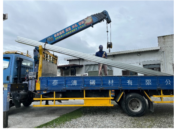
地基結構鋼材備料進場
