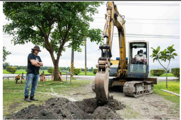
地基開挖立結構
