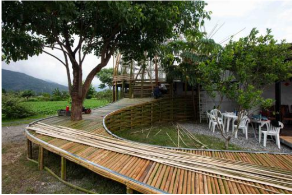
高台結構工程
