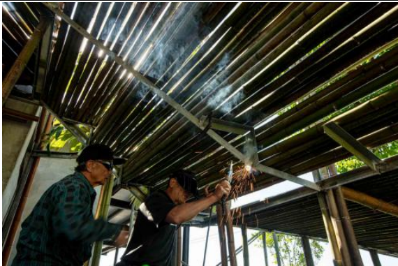
鋼鐵架構固定工程
