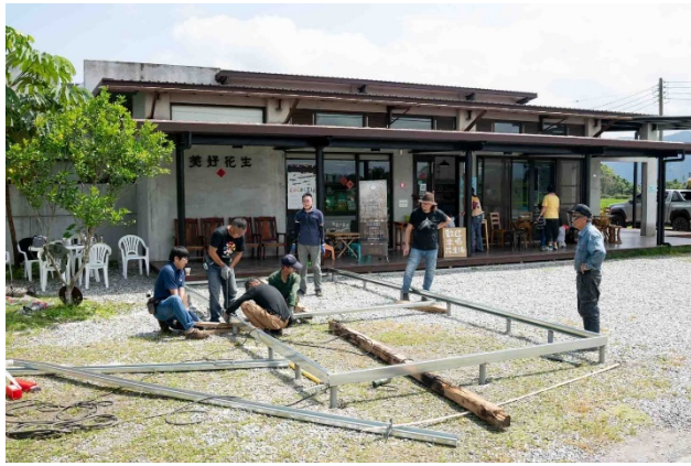
鋼材結構處理
