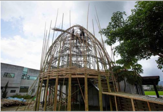
作品主體結構造型定型與編織製作工程
