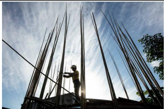
作品主體結構工程建構
