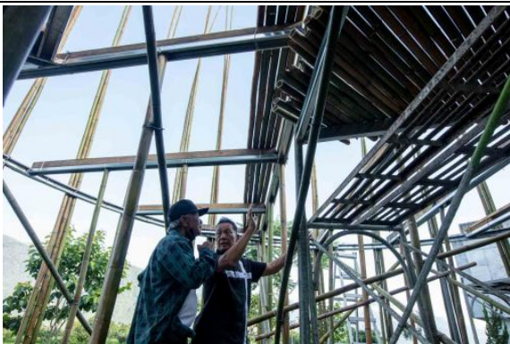
作品主體結構工程建構
