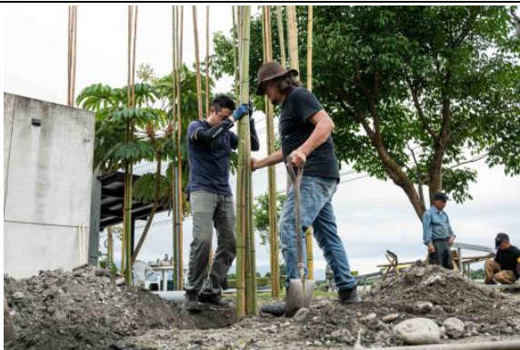
地基開挖立結構
