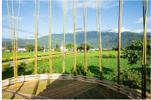
高台結構工程
