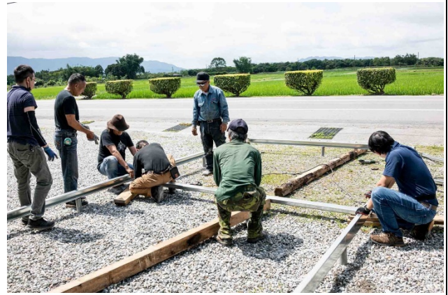
鋼材結構處理
