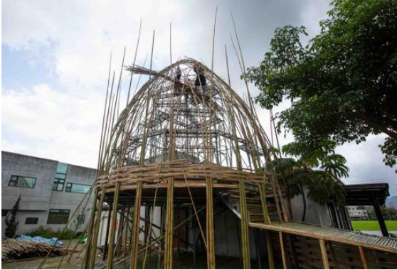
作品主體結構造型定型與編織製作工程
