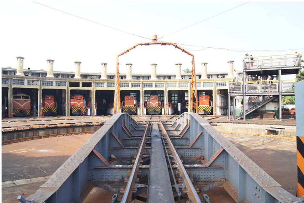
扇形車庫於1922年(大正11年)完工使用，同年鐵道官舍也開始興建(官舍建築群正確興建時間仍有待考據)
