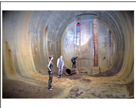
圖14 半屏山地下水庫爬梯與水管
