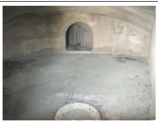
圖10 半屏山北砲臺下層砲堡內部
