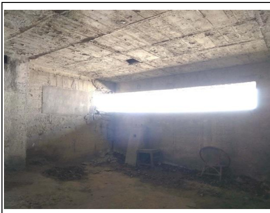
圖11 半屏山北砲臺中層砲堡內部
