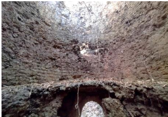
圖 88 金京潭石灰工廠三號窯
