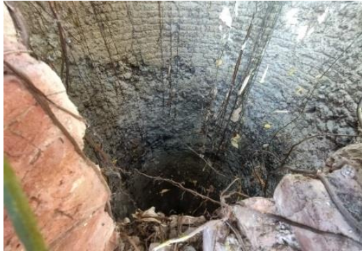
圖 47 臺灣石灰第二工場石灰窯
