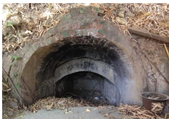
圖 41 臺灣石灰第一工場石灰窯火口
