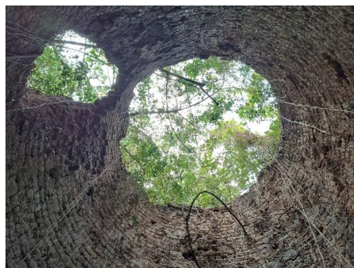
圖 91 金京潭石灰工廠三號窯
