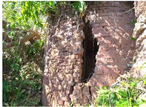
圖 48 臺灣石灰第二工場石灰窯
