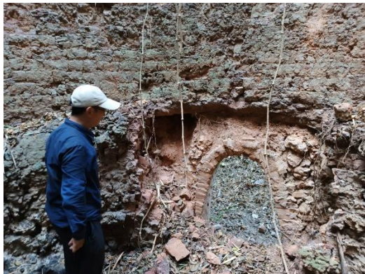
圖 90 金京潭石灰工廠三號窯
