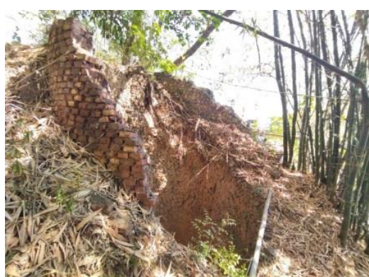
圖 42 臺灣石灰第一工場石灰窯窯頂
