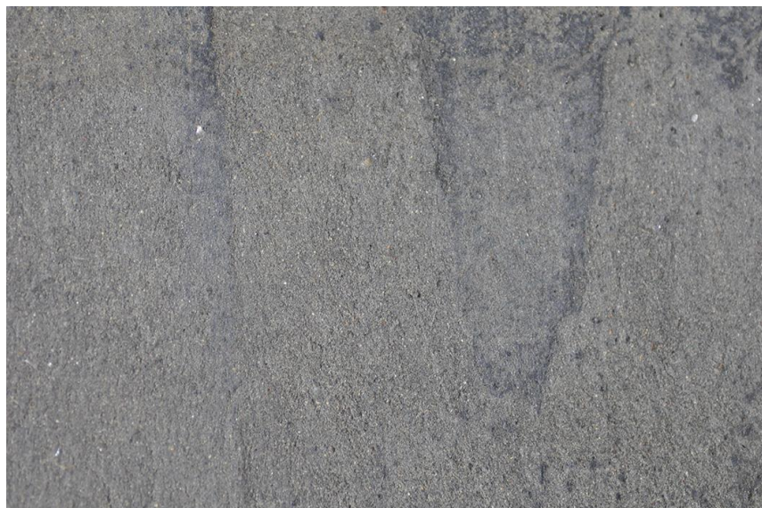
(圖.19) 漆灰乾固後研磨平整。
