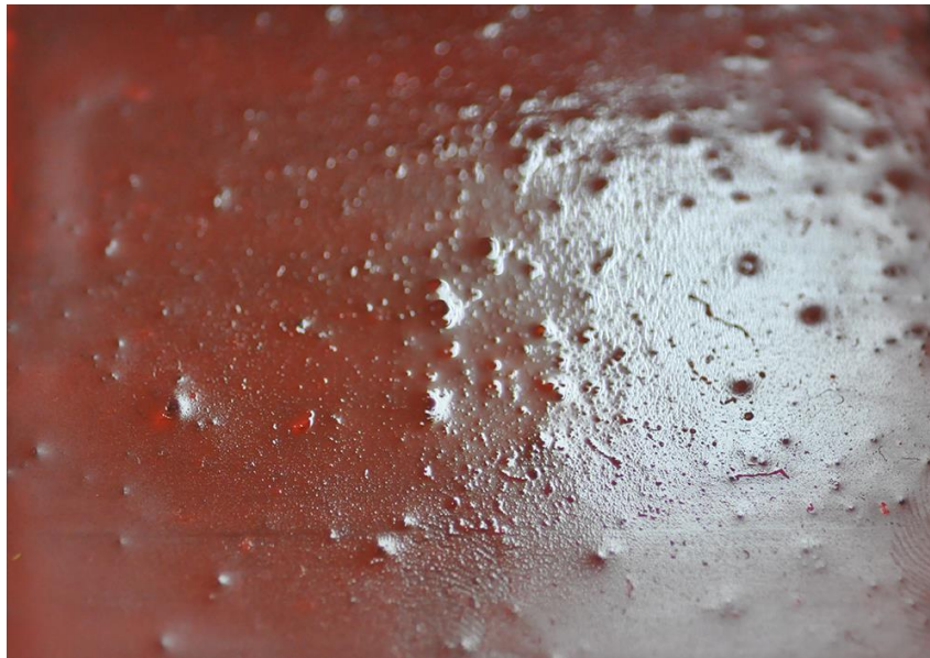
(圖.69) 色漆加入過多沙拉油使漆層無法完全硬化。
