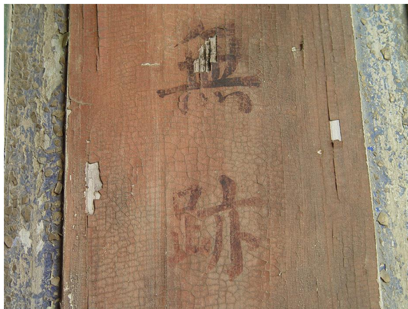
(圖. 64)加入過多桐油，長年後劣化。
