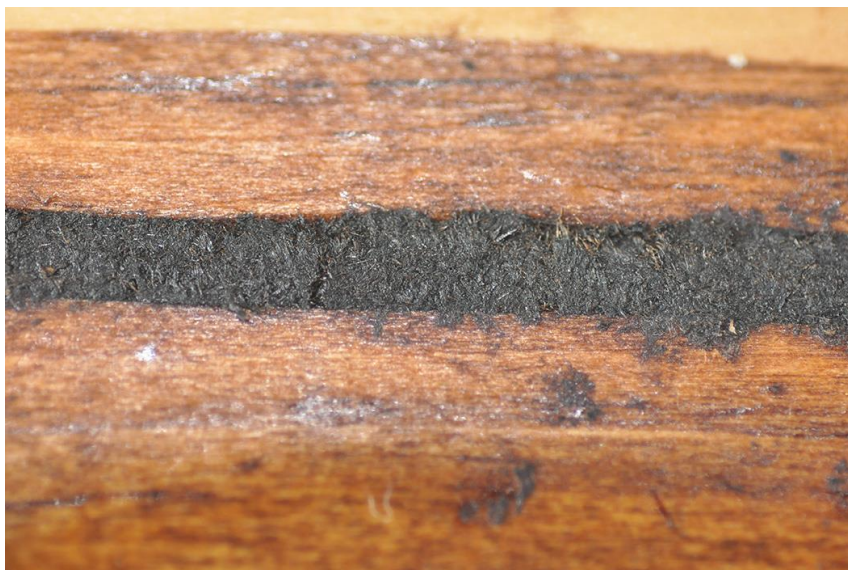
(圖.4)剛調好的刻苧灰填平凹槽，填補部位尚未乾固凹陷。
