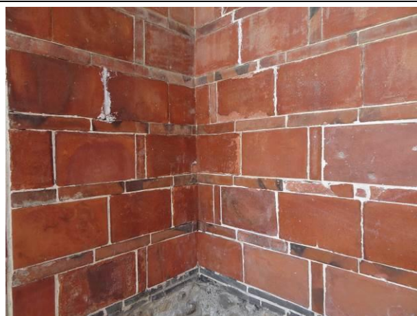
圖 0-17 斗子牆(永靖餘三館)
