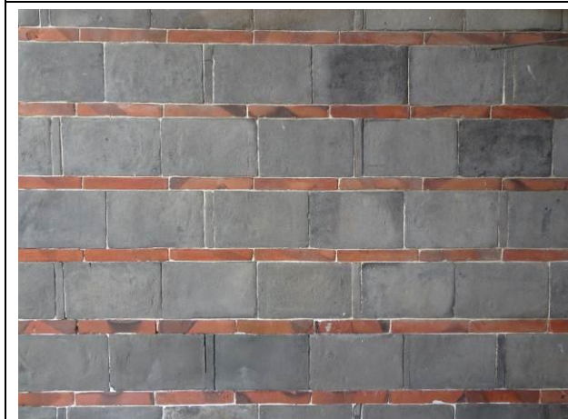
圖 0-16 斗子牆(永靖餘三館)
