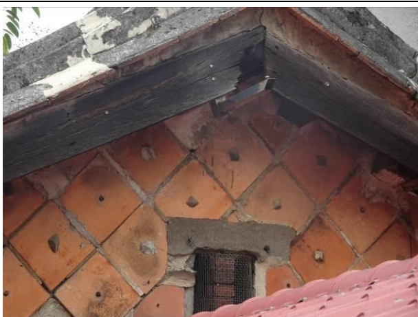
圖 0-26 穿瓦衫(台北市大安區民宅)
