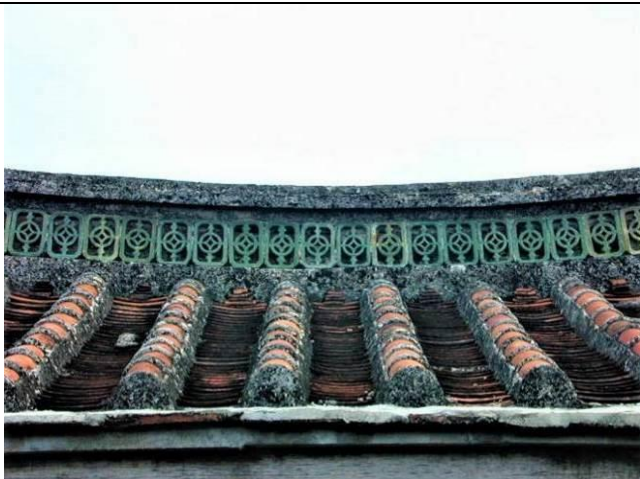
圖 0-75 琉璃花磚(澎湖縣湖西鄉港子尾民宅)
