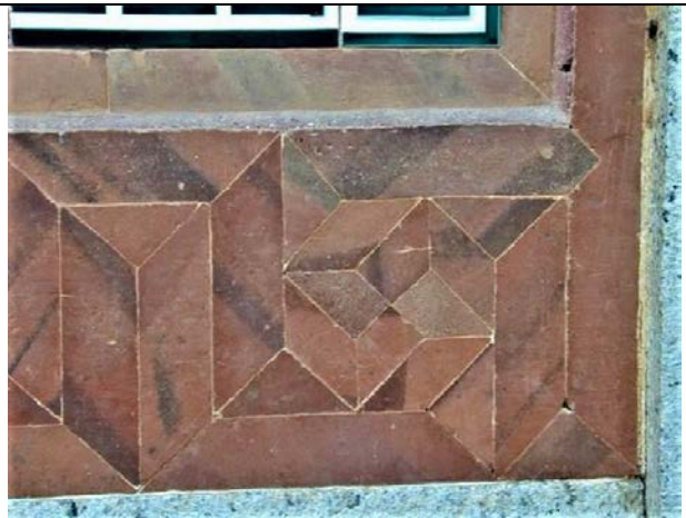
圖 0-54 磚組砌(金門縣金沙鎮民宅)
