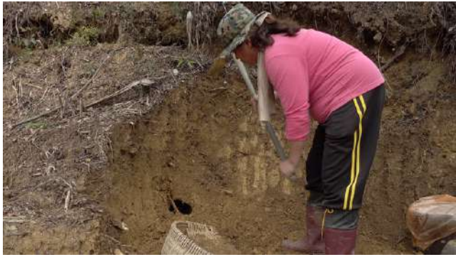
挖土，製作遮擋處
