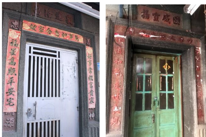
圖 2- 10 左營一甲梁家古厝虎邊外護龍的門額(左營新路 151 號)
