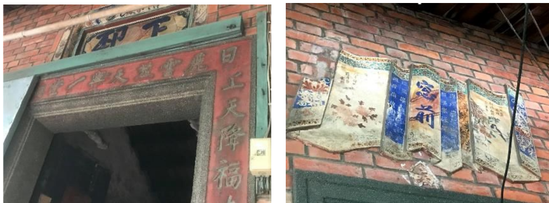
圖 2- 6 左營一甲余家下邳大厝(左營下路 153-3 號後側)
