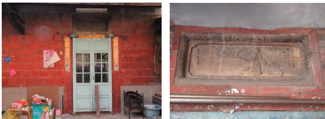
圖 2- 9 左營一甲梁家積善家古厝(左營新路 147 號)
