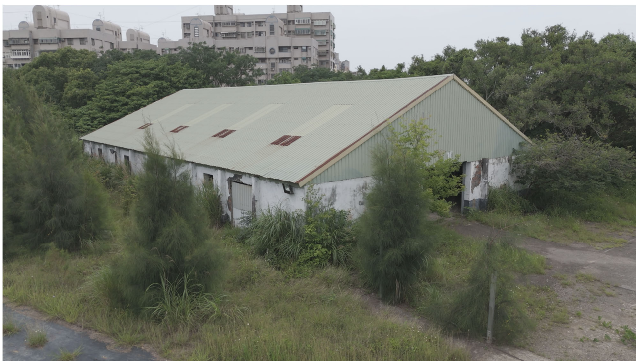
圖四：觸媒工場現存廠房—編號11號庫房外觀。資料來源：本計畫拍攝。
