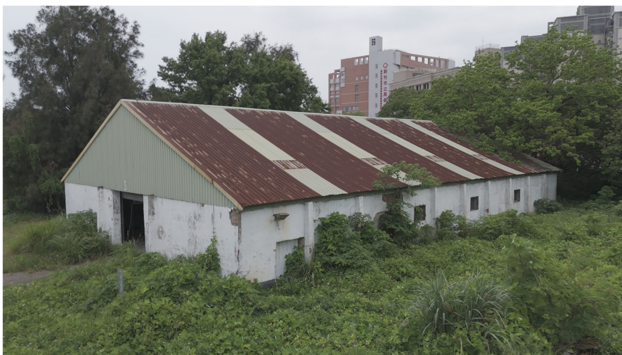
圖二：觸媒工場現存廠房—編號9號庫房外觀。資料來源：本計畫拍攝。
