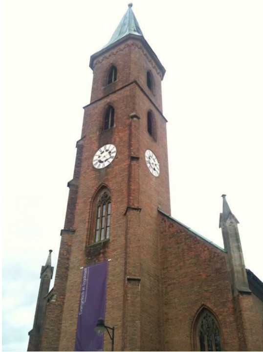
St. Matthaus ,Ingolstadt 外觀
