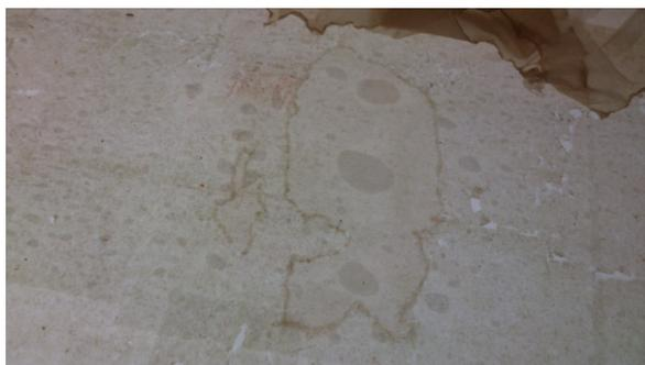
圖 56.以 0.15cm 毛邊方式搭貼隱補破損
