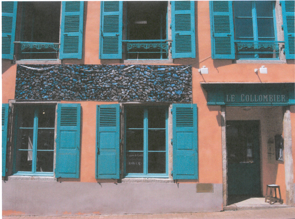
說明：駐村中心外觀 (住宿起居區為3樓-4樓部份)。
