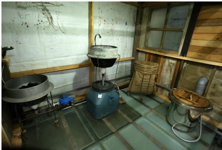
移動式廁所 尺寸：250*250*200cm / 複合式回收材料 / 年代 2015 此空間提供身體排放尿液與糞便並回收再使用，內部水資源做基本等高位差作為清潔水利用
