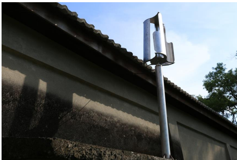
風力發電機 尺寸：200*50*50cm / 不鏽鋼、發電機模組 / 年代 2015 此風力發電機提供四盞燈泡使用，其一 LED 放置於移動式廁所
