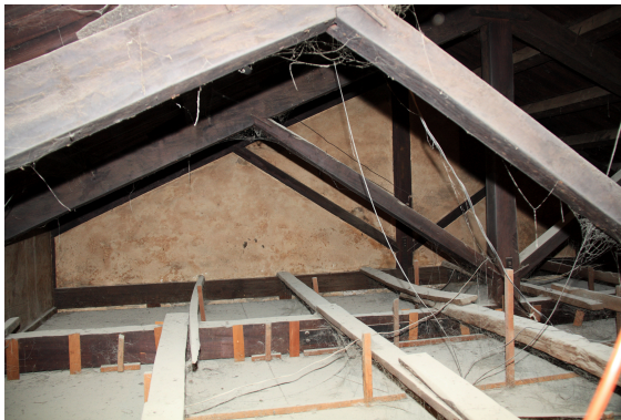
照片 3-5 明間屋架實況 (本研究拍攝)
