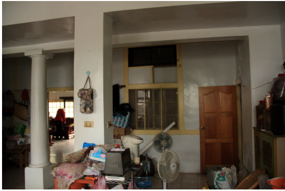
照片 3-9 後側廚房後廊柱子仍為原樣 (本研究攝影)
