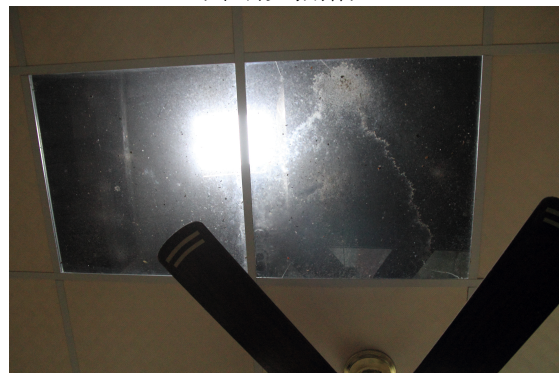
照片 3-8 原來廚房的煙囪痕跡 (本研究拍攝)
