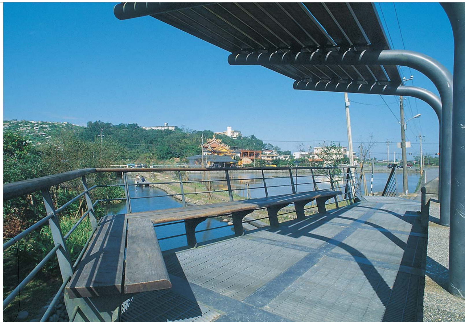
▲公埔橋上的橋亭提供了良好、舒適的休憩空間。
